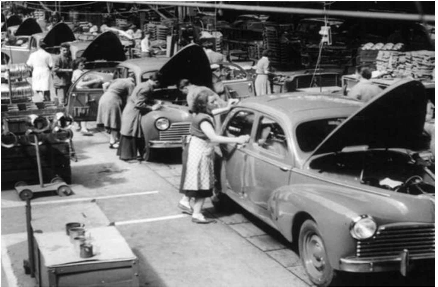
Ligne de montage des Peugeot 203 (1951)
