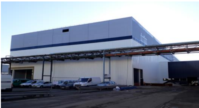
Bâtiment du nouvel emboutissage M42
