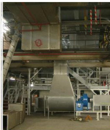
La ligne D équipée de ses nouvelles installations.
