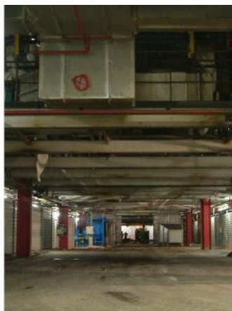
La ligne D démontée .....
